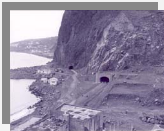
Túnel viejo y nuevo.
